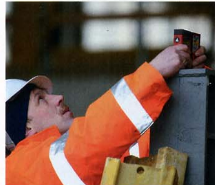
Zeigen die Messungen, dass die Konstruktion schief ist, wird gestoppt und alles wieder ins Lot gezogen.
