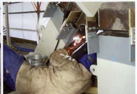
Während der Schweißarbeiten
