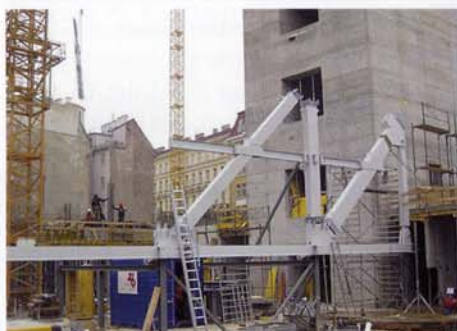
Zusammenbau der Fachwerk-Stahltragkonstruktion in Bodennähe.
