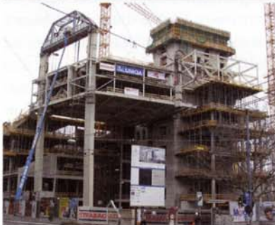
Endposition, in der die beiden Teile der Tragekonstruktion miteinander verschweißt werden
