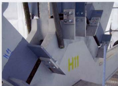
Ein Fachwerkknoten ist für den Schweißvorgang vorbereitet.
