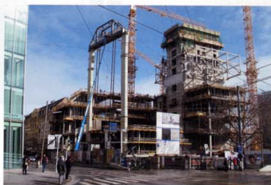
Ausgangsposition nach dem Betonieren der Decken © Zeman & Co. GmbH
