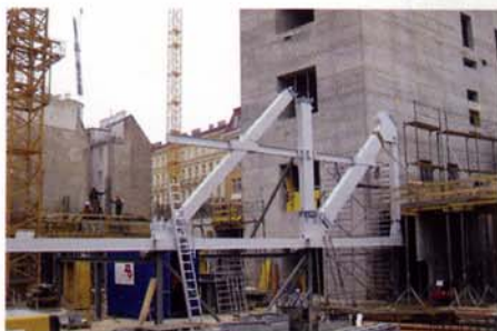
Zusammenbau der Fachwerk-Stahlkonstruktion © Zeman & Co. GmbH
