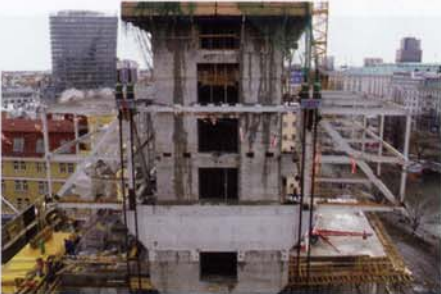
Zwei Anhebepunkte mit je zwei Litzenbündel © Zeman & Co. GmbH
