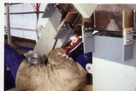
Während der Schweißarbeiten © Zeman & Co. GmbH
