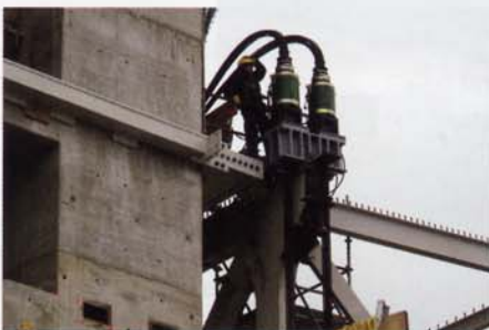
Anhebepunkt mit je zwei Hebern © Zeman & Co. GmbH
