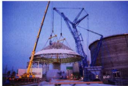
Zeman HDF in Polen: Planung, Konstruktion und Ausführung aus einer Hand
