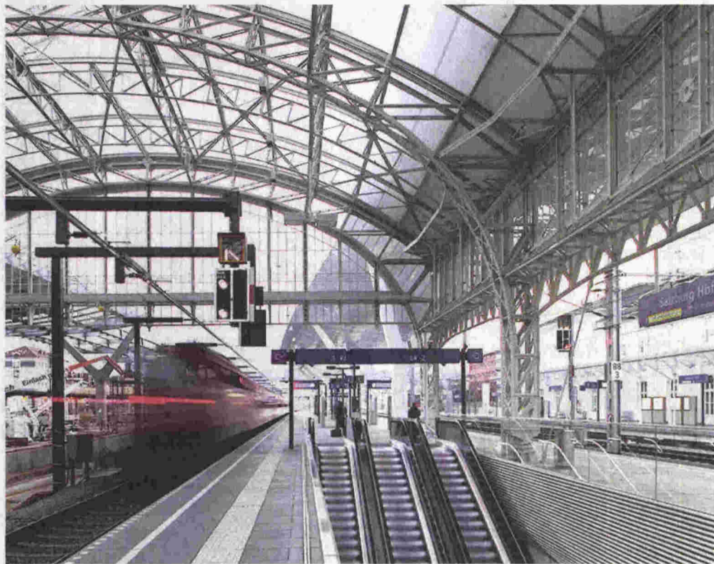
Salzburg Hbf: Bei der Sanierung der historischen Bahnhofshalle wurden 2000 Einzelteile restauriert
