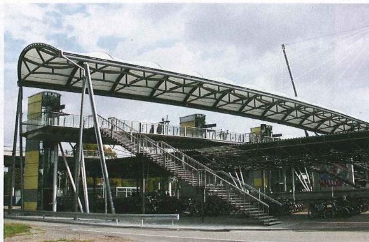
Zeman realisierte das 85 Tonnen schwere Stahldach im deutschen Wiesloch. Besonders spektakulär gestaltete sich die Einhebeaktion der Konstruktion.
