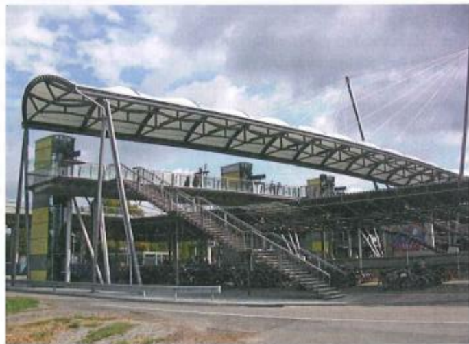
Ein Teil der Überdachung lag über der bereits bestehenden Fußgängerüberführung, welche die DB AG-Strecke 4000 beim Bahnhof Wiesloch Walldorf kreuzt.
