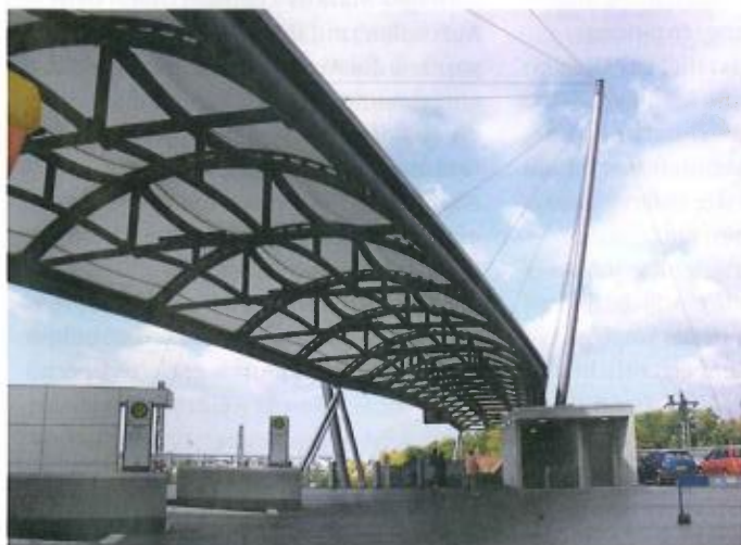
Aufgrund der Nähe zum Gleiskörper der Deutschen Bahn waren für die Montage über den Gleisen nur bestimmte Zeitfenster vorgesehen.
