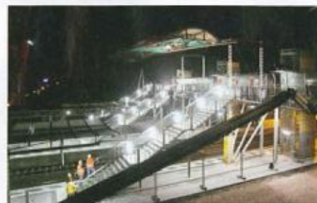
Mit einer spektakulären Aktion wurde die Dachkonstruktion, die nun Fußgängersteg und Gleise überdeckt, eingehoben.
