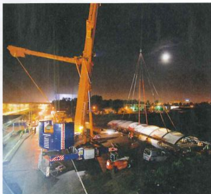
Jeweils eine Hälfte des Dachtragwerkes wurde am obersten Deck des Parkhauses bzw. in einer angrenzenden Grünfläche komplett zusammengebaut und mit einem 500-t-Kran auf die Endauflager bzw. Hilfskonstruktion eingehoben.
