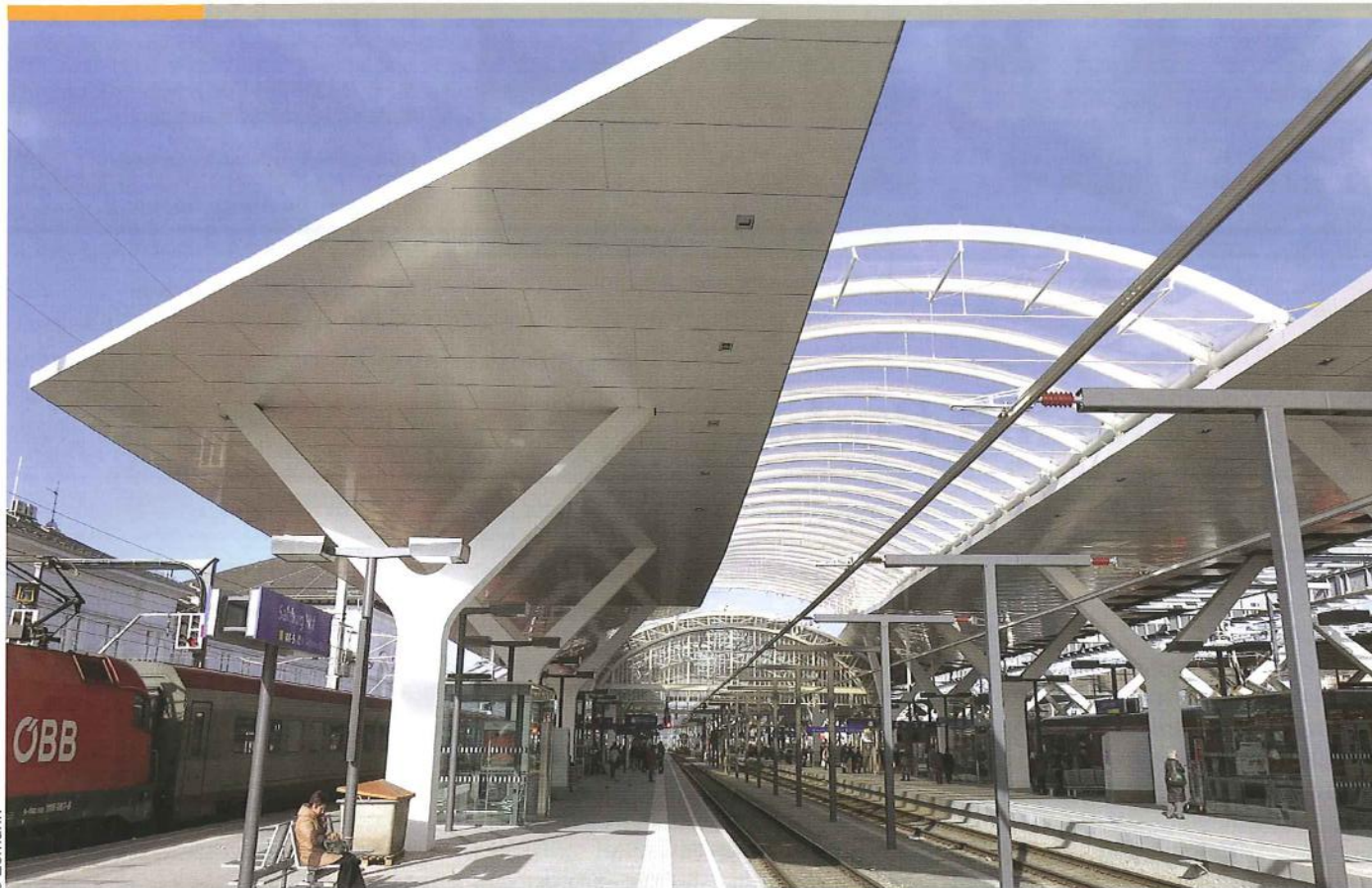
Preisgekrönt: Hinten die restaurierte, historische Stahlkonstruktion, vorne die neue Bahnsteigüberdachung.
