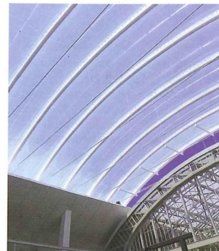
Die Gleisüberdachung ist mit einer filigranen, hochtransparenten Folienkissen-Dachkonstruktion verbunden.
