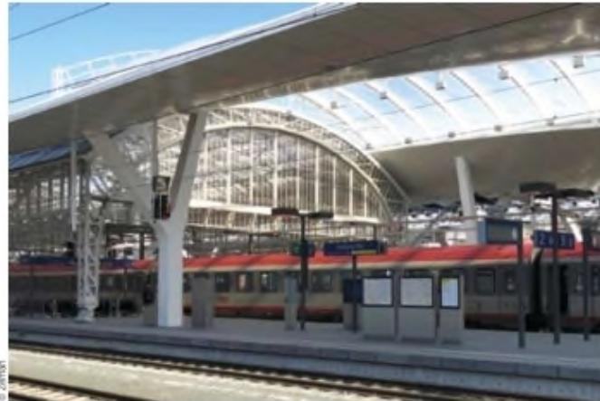
Die historischen Tonnendächer wurden in die neue Konstruktion integriert.
