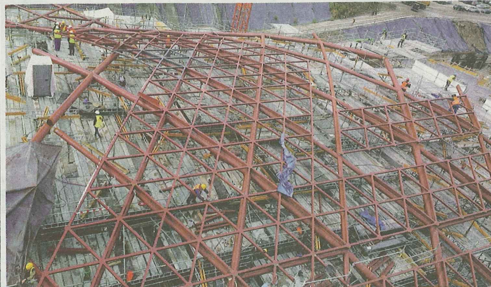
Wiener Hauptbahnhof: Stahlbau für die Fassaden und die Dachkonstruktion mit der integrierten Haustechnikzentrale (li). Bahnhof Łódź Fabryczna in Polen: Räumlich gekrümmtes Stahl-Glasdach (re.)
