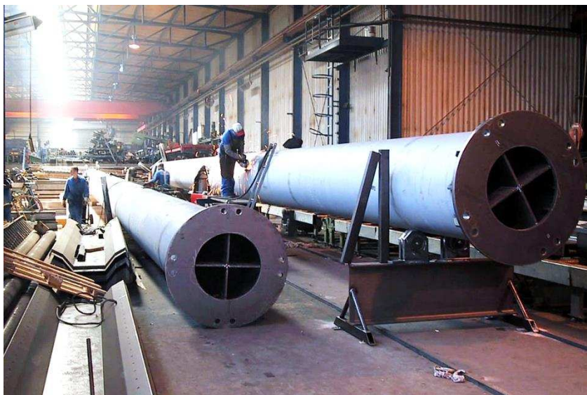
Fertigung zweier Pylone in der Produktionshalle View inside the production hangar, fabrication of two pylons
